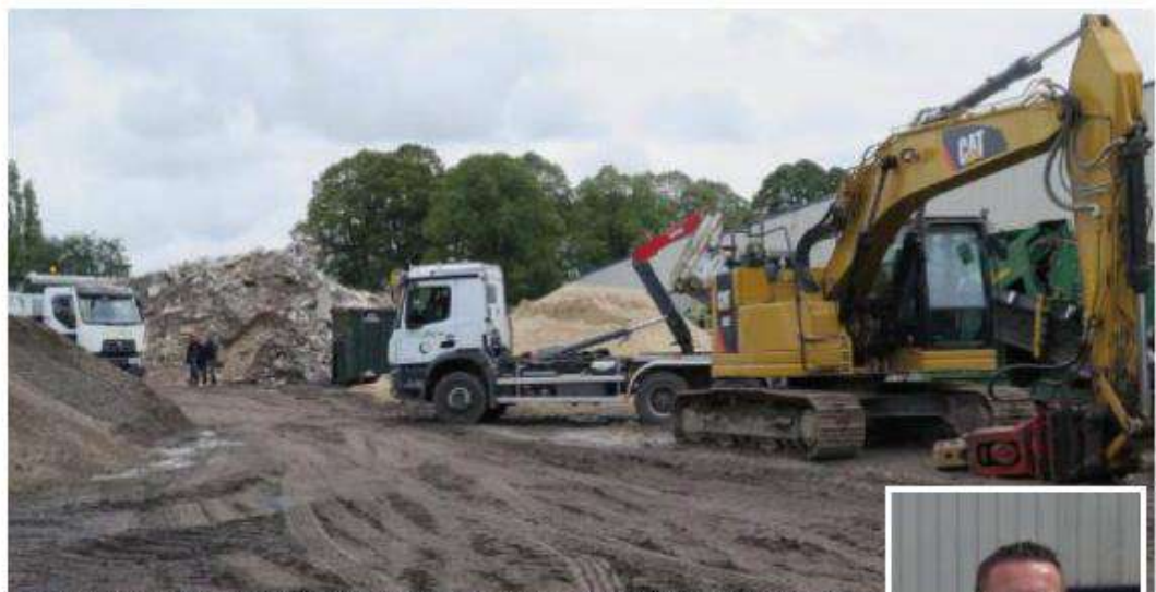
Le site de vente de matériaux en vrac a commencé son activité. Mais les travaux d'aménagement des voiries commencent seulement. Dans la foule sera aussi construite la déchetterie 24 h sur 24 qui sera ouverte aux professionnels du BTP abonnés.
