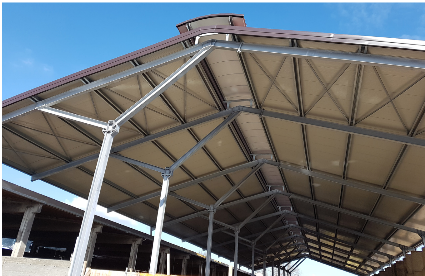
Couverture pour élevage, en détail faitage ventilé en panneau DELTA 5 Isolpack. Cover for breeding, in detail ventilated ridge DELTA 5 Isolpack panel.
