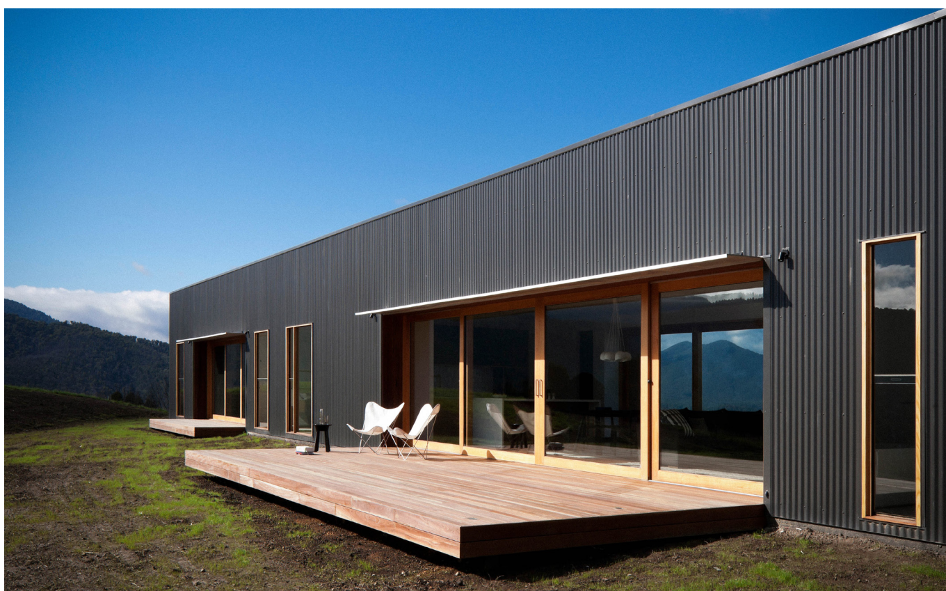
Revêtement pour bâtiment résidentiel en ISOGREK H28 Wall cladding for residential building made with ISOGREK H28.
