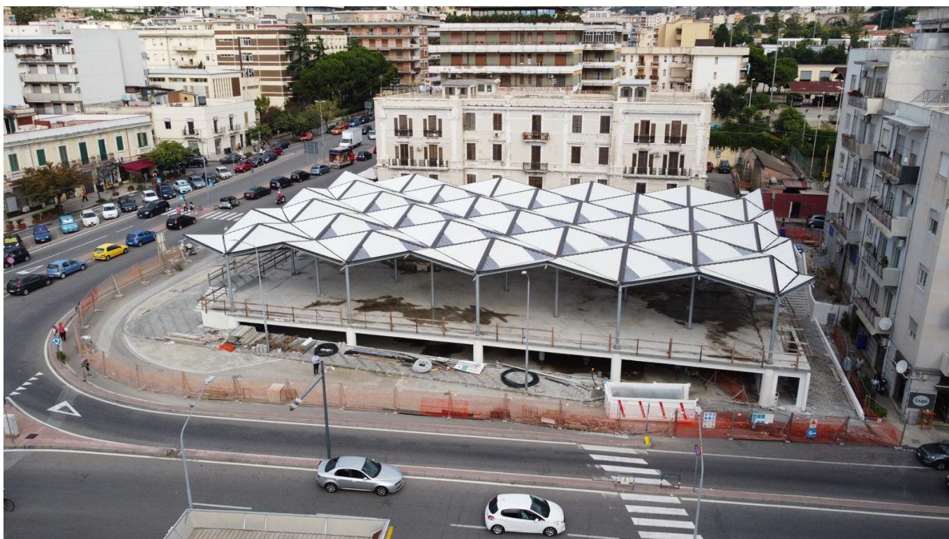
Marché couvert de Messina réalisé avec des 5 panneaux ISOMETAL 5G. Covered market of Messina made with ISOMETAL 5G panels.
