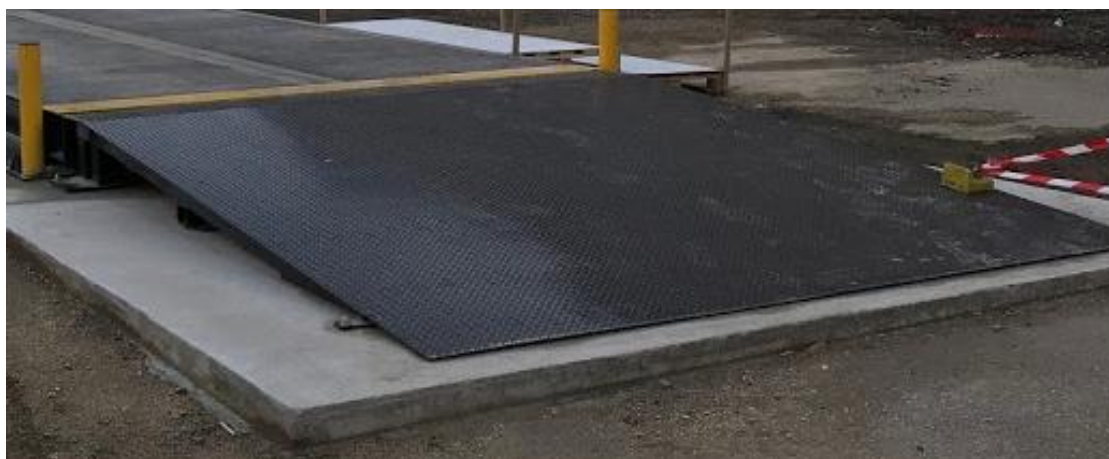
Rampes d'accès pleines
