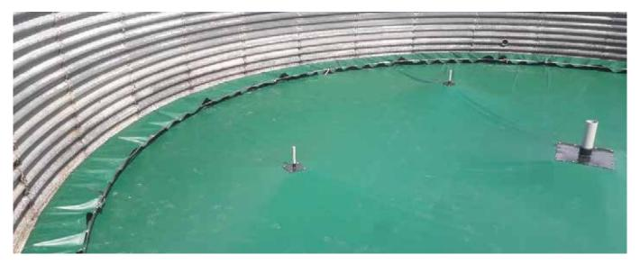
Pour les constructions de silo qui ne peuvent pas accueillir une toiture, une bâche flottante est une excellente alternative. La bâche, qui est produite sur mesure, flotte sur le lisier et monte et descend avec le volume du lisier. L'eau de pluie collectée sur la couverture peut être pompée, de sorte qu'elle ne se mélange pas au lisier et que le silo peut être rempli à pleine capacité.
