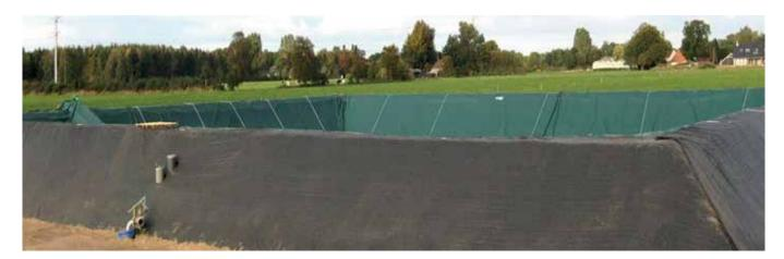
Le bassin à lisier Genap est un bassin creusé certifié Kiwa pour le stockage de différents types de lisiers et de digestats. Le bassin est creusé et recouvert d'une membrane. Les digues autour du bassin sont construites à l'aide du sol libéré. Vous pouvez commander un bassin à lisier de n'importe quelle taille; nous le fabriquons sur mesure.
