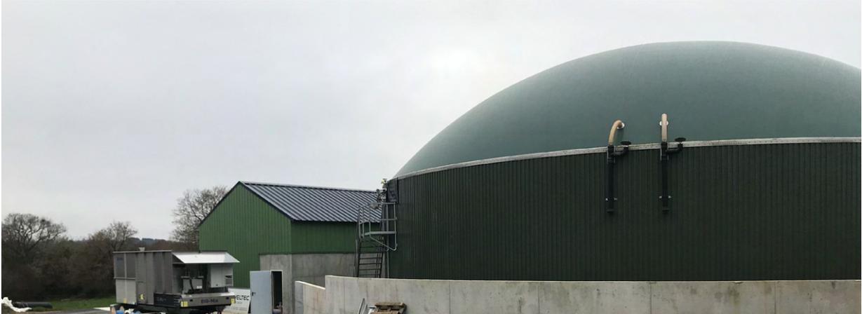
Installation avec injection biométhane de 100 Nm<sup>3</sup>/h CH<sub>4</sub> - 2 digesteurs de 3 176 m<sup>3</sup> et Ø 25,34 m - Manche (50)
