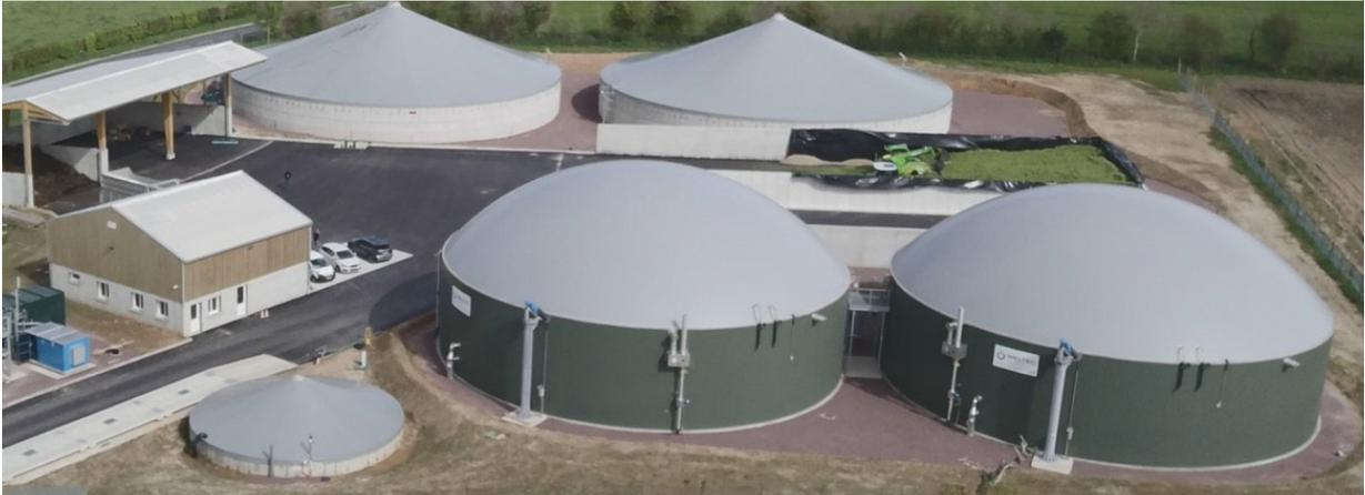
Installation avec injection biométhane de 250 Nm<sup>3</sup>/h CH<sub>4</sub> - 3 digesteurs de 4 436 m<sup>3</sup> et Ø 29,94 m - Calvados (14)
