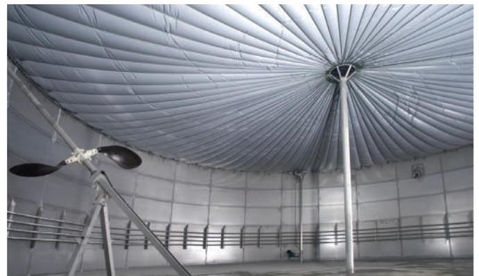
Intérieur d'un digesteur en acier inoxydable
