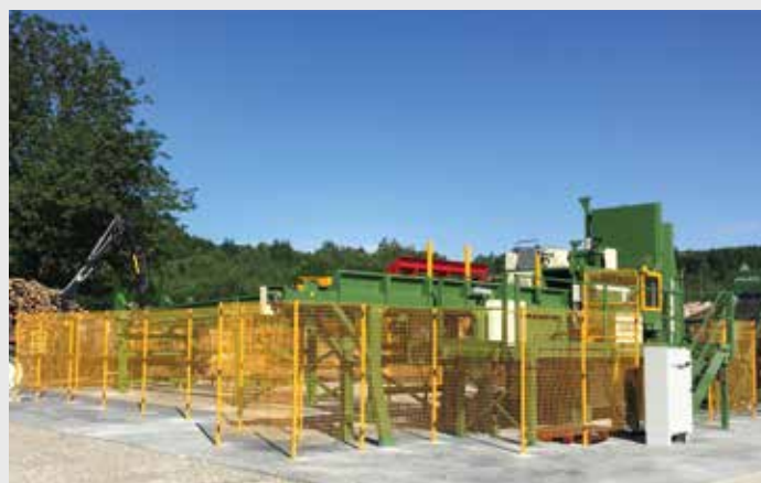
Barrières de sécurité pour délimiter la zone de travail
