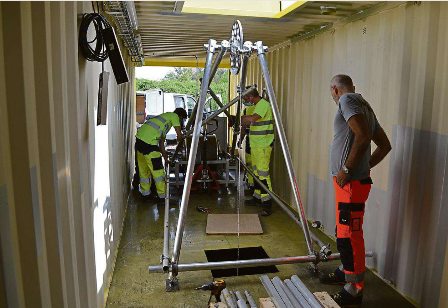
La sonde, mise à disposition des chercheurs par la Française de l'Energie, est capable de descendre à 1.100 mètres de profondeur et a permis de détecter de l'hydrogène, pour une teneur de 1 % à 600 mètres puis de 17 % à 1.100 mètres. DR
