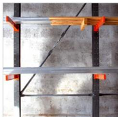
Contreventements constitués de traverses et diagonales en tube rond Ø35 et d'un tendeur à lanterne pour le réglage de la verticalité
