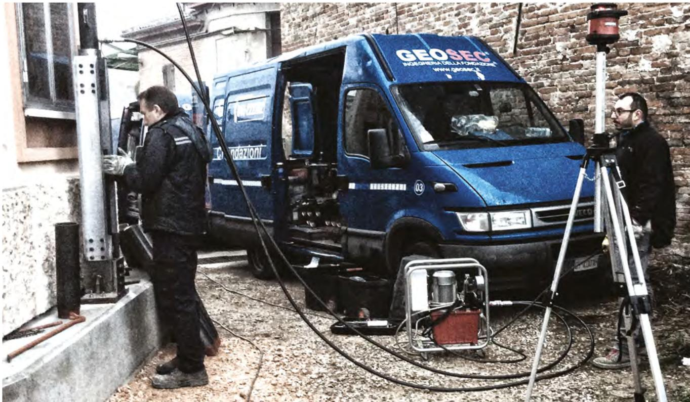
Une fois le système d'enfoncement positionné, nous procédons à l'insertion d'éléments modulaires séquentiels, qui formeront le pieu de fondation. Chaque élément est mis en place grâce à la poussée du système d'enfoncement, piloté au-dessus du sol par les techniciens **GEOSEC®**.
