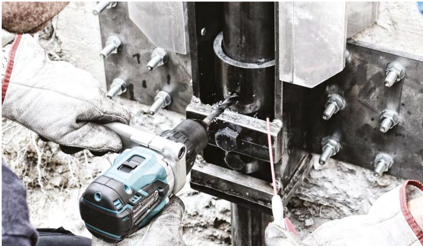
Une fois que la profondeur de la couche du sol d'ancrage a été atteinte ou la pression de refus, des charges plus élevées que celles de fonctionnement peuvent être appliquées créant une inhibition de l'affaissement primaire post-connexion. Ensuite, le pieu sera fixé à la fondation d'origine, grâce à l'utilisation d'une platine d'ancrage. Enfin, après avoir fixé le dernier élément, on procède en coupant la partie du pieu en excès au niveau de la tête.
