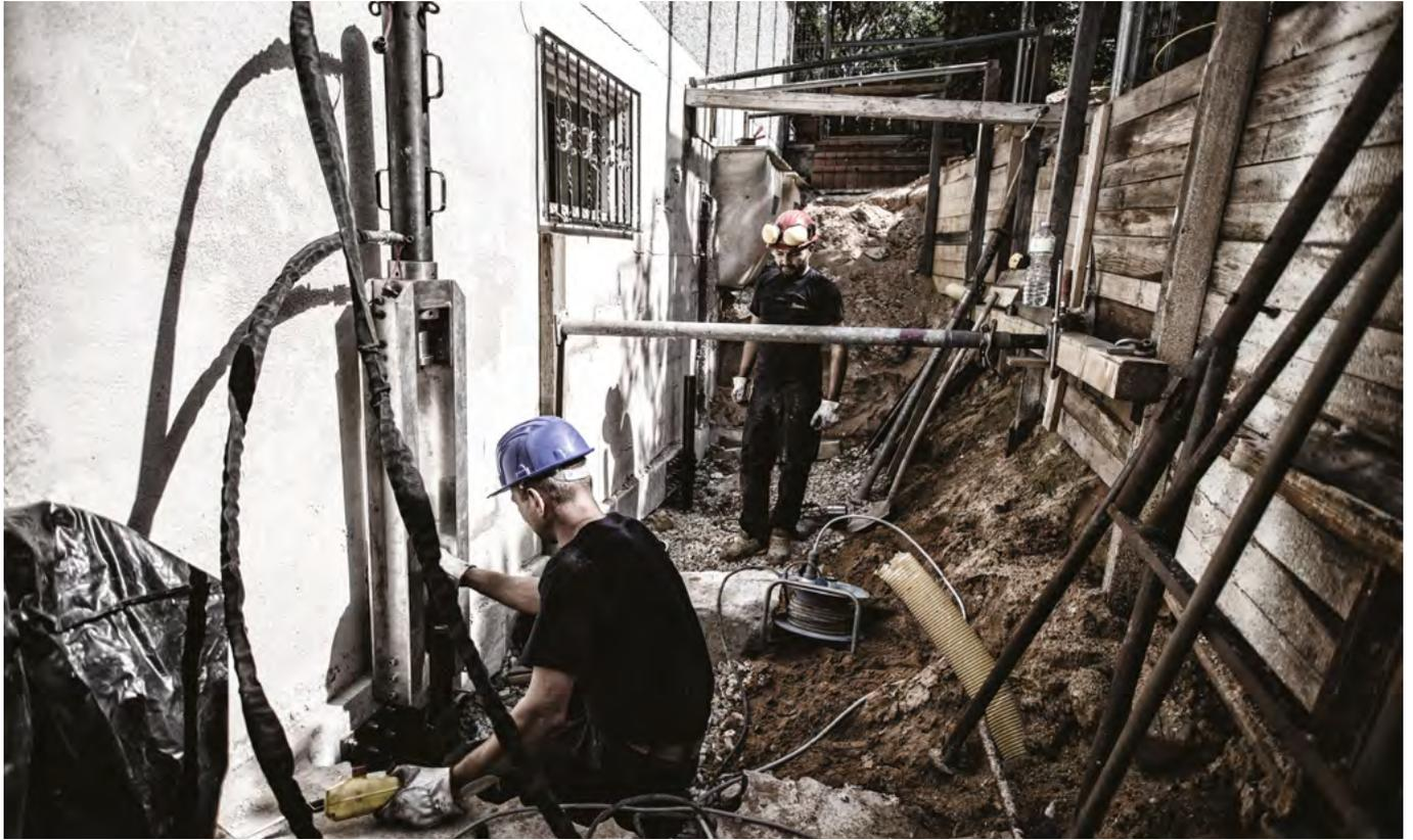
Pour la pose des micropieux, il peut être nécessaire de réaliser des excavations à proximité de la structure de la fondation d'origine, de manière à garantir la pleine opérativité en complète sécurité de nos travailleurs.
