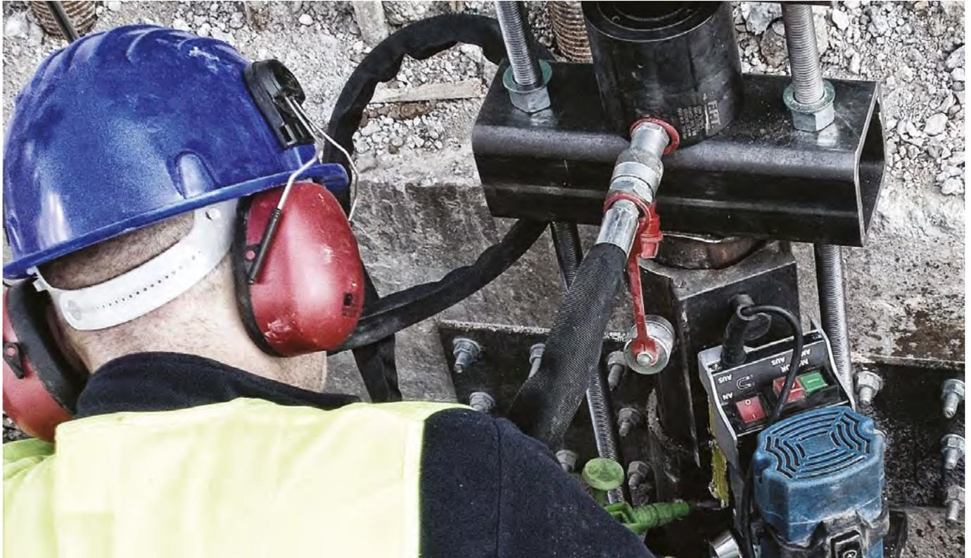
En général, les micropieux (diamètre <math>< 300\text{ mm}</math>) sont couramment utilisés dans deux applications principales: comme **éléments de structure et pour le renforcement du terrain**. L'utilisation comme éléments de structure comporte de nouvelles fondations, des pieux de sous-fondation, des améliorations statiques d'anciennes structures et des travaux de support de terrain.
