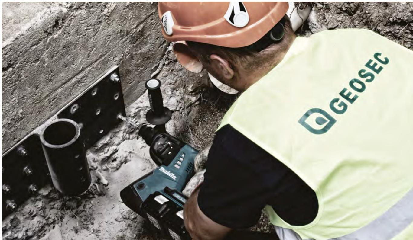
Une fois que l'intégrité et l'adéquation de la structure de fondation d'origine ont été vérifiées, des platines d'acier de taille appropriée sont posées pour accueillir l'accrochage du système de poussée du pieu et pour permettre la liaison micropieu / fondation existante.
