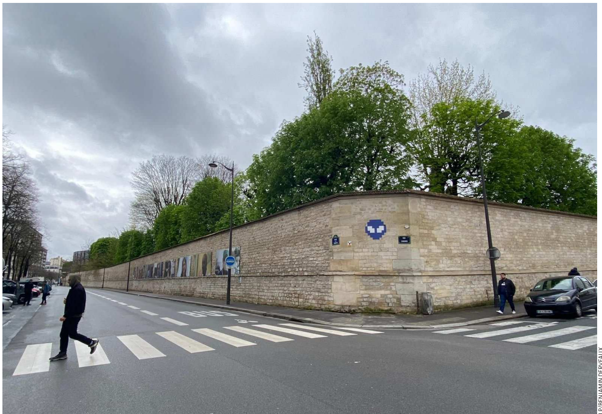
Paris XIII e , ce mercredi matin. C'est au niveau du 93, rue de la Santé, près de l'hôpital Sainte-Anne (derrière ce mur) et à 450 m du centre pénitentiaire, qu'un technicien a découvert ce qui ressemble à une galerie.
