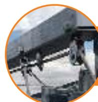
Ouverte et fermeture grâce à une corde et un système de poulies
