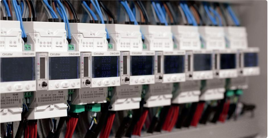
L'installation d'analyseurs de réseaux nous fournit des informations en temps réel sur les variables électriques, telles que le niveau de tension, courant ou harmoniques, pour analyser la qualité de notre installation ; ainsi que des données de consommation afin de connaître notre consommation d'énergie, le moment où nous la consommons, le lieu où nous la consommons et comment nous la consommons.
