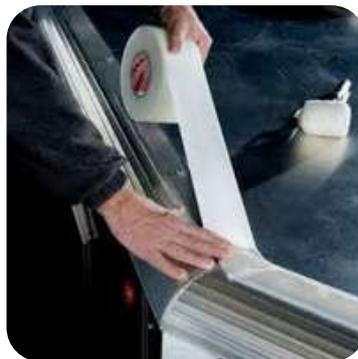
**Etanchéité profilé plaque avec recouvrement**
